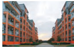
上海复旦大学公寓楼
